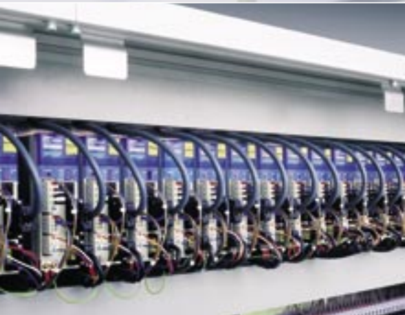
27 serwonapędów SmartSteps steruje transportem dokumentów.
