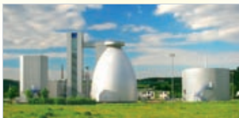
DCS per centrale elettrica (controllo centrale, monitoraggio e sistema di protezione)
